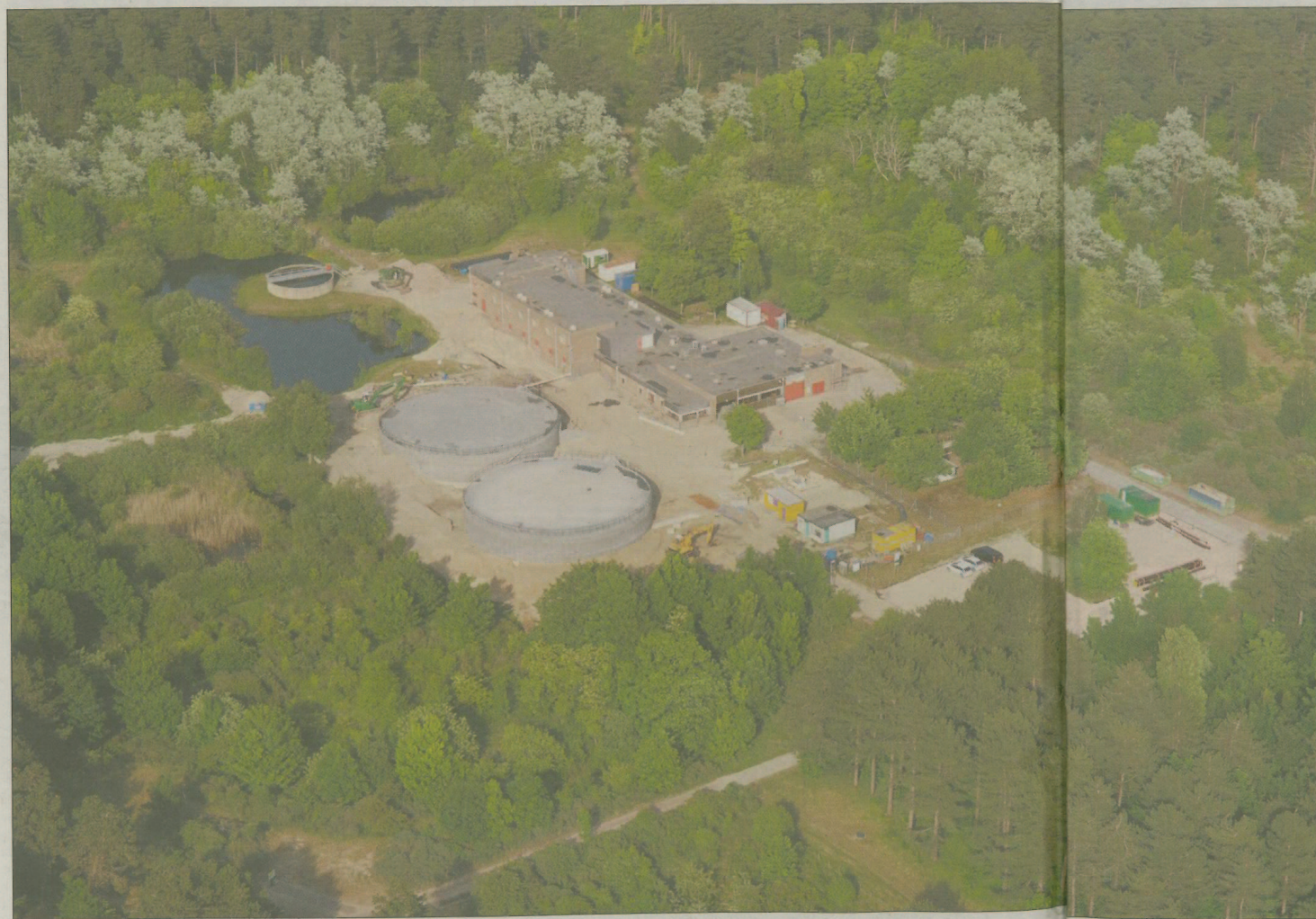
De laatste ingrijpende verbouwing van het waterpompstation is achter de rug. Twee nieuwe reinwaterkelders bergen elk 3000 kuub drinkwater.
